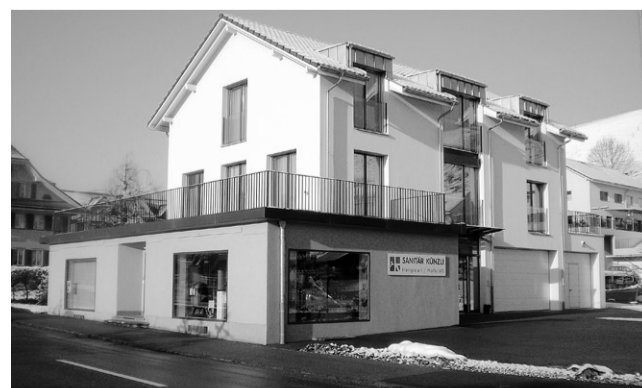
Das 2006 neuerstellte Wohn- und Geschäftshaus Chrüzmätteli im Dorfkern von Hergiswil.
